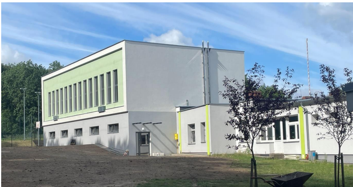
Ilustracja 12 Sala sportowa przy Szkole Podstawowej nr 2 w Wapnicy (zdjęcie SP 2 w Wapnicy)
