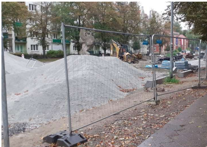
Fot.1. Przykład ogrodzenia ochronnego
