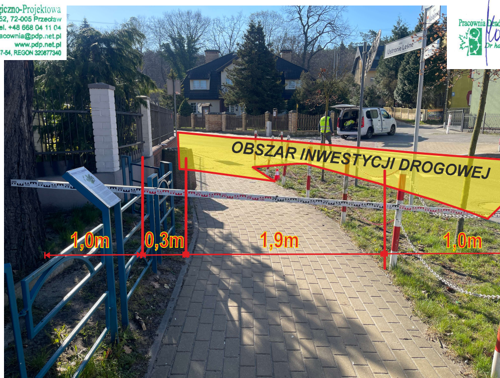
Fot. 9. Obszar inwestycji drogowej w części najbliższej pomnikowi przyrody dębu REGALINDA
